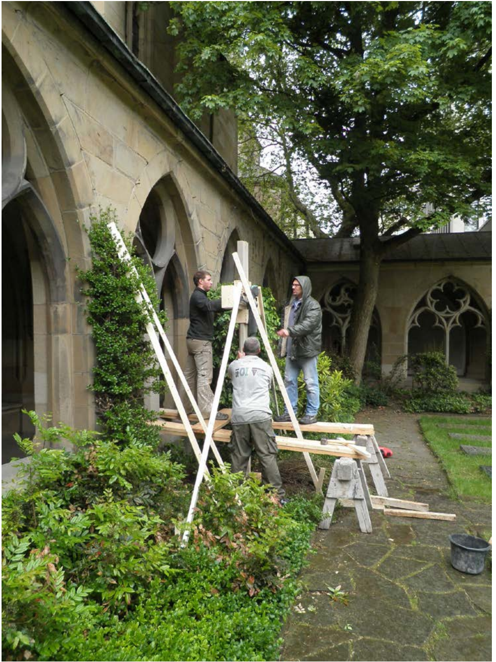
Restaurierung Kreuzgang Essener Münster
